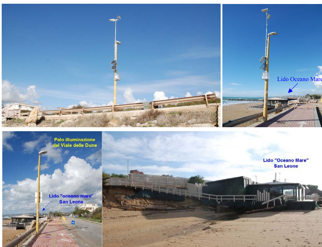
Figura 2: Il palo dell'illuminazione del Viale delle dune sul quale è installato il Sistema di Video-Monitoraggio.
